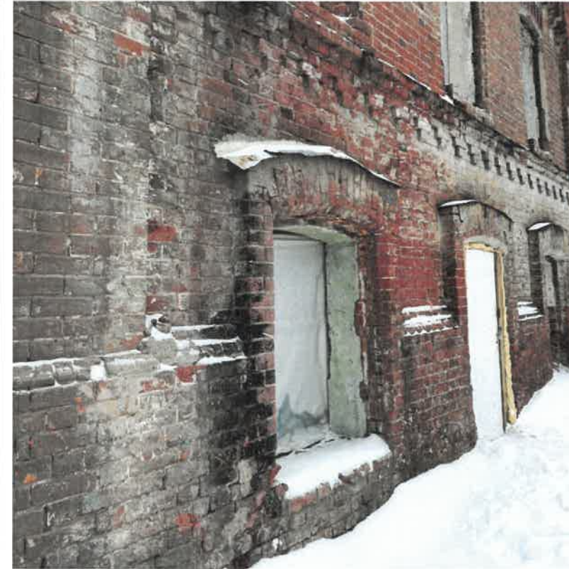
Детали главного фасада (февраль, 2023 г.)
