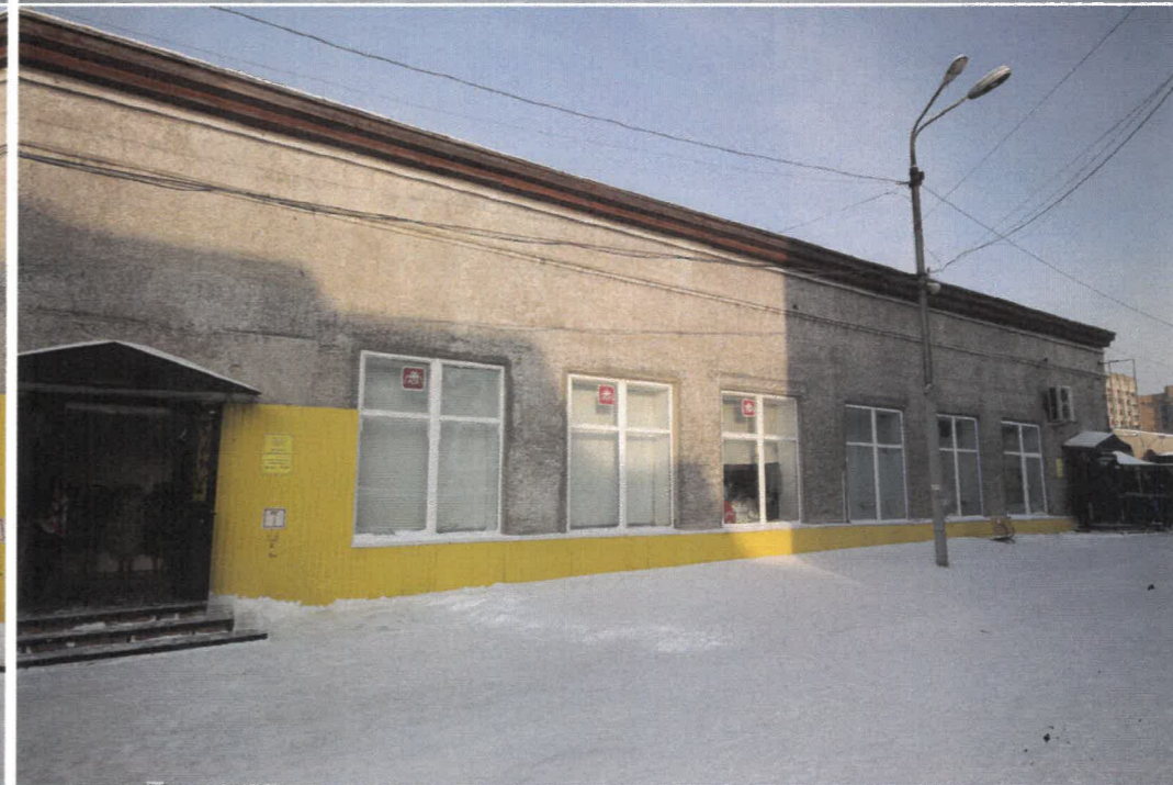
Фрагмент дворового фасада
