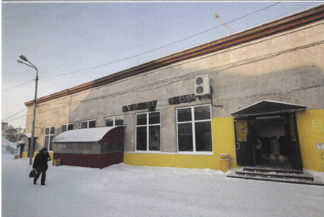
Фрагмент дворового фасада
