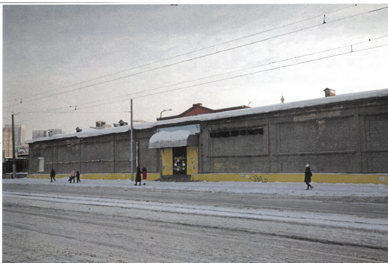
Фрагмент главного фасада по ул. Пушкина
