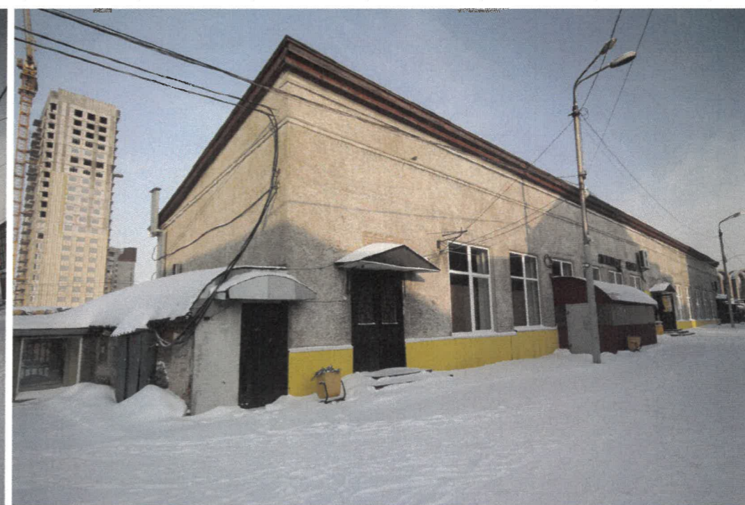
Фрагмент дворового фасада
