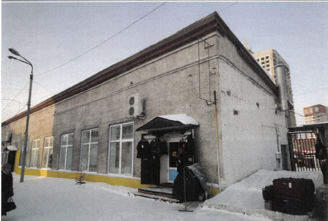
Фрагмент дворового и бокового фасада
