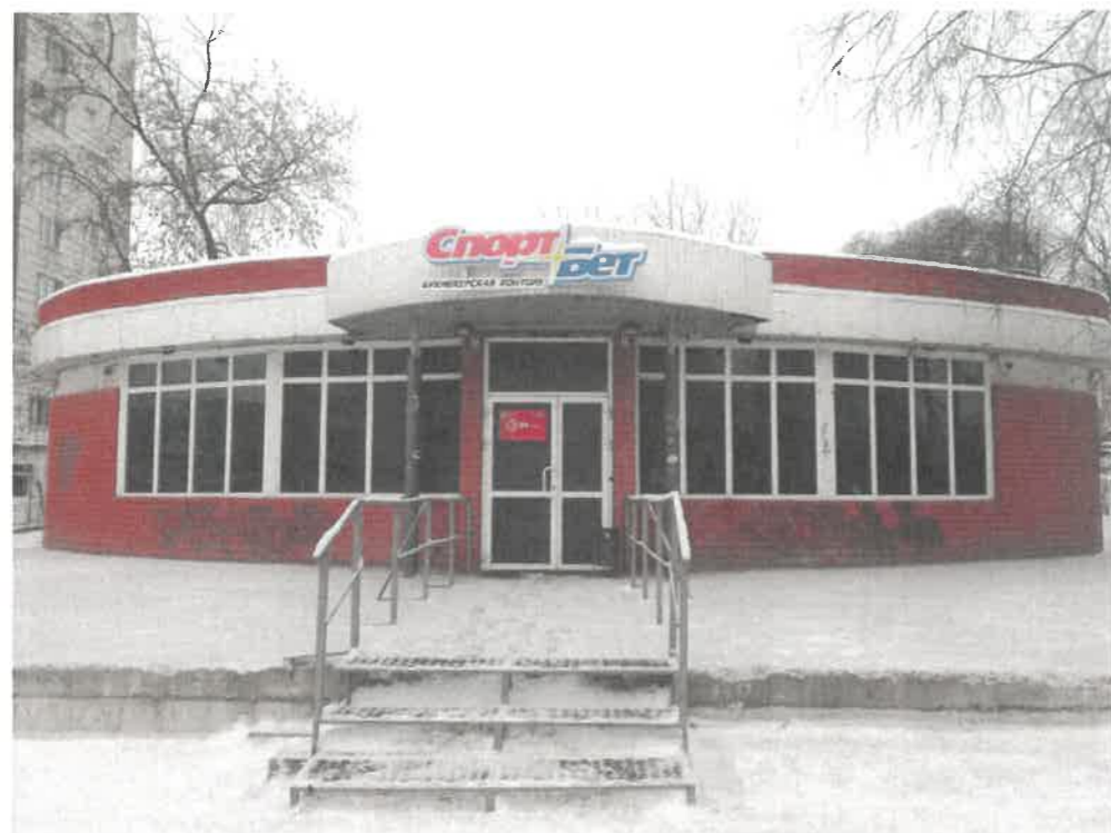
Главный фасад в осях А-Б (существующее положение)
