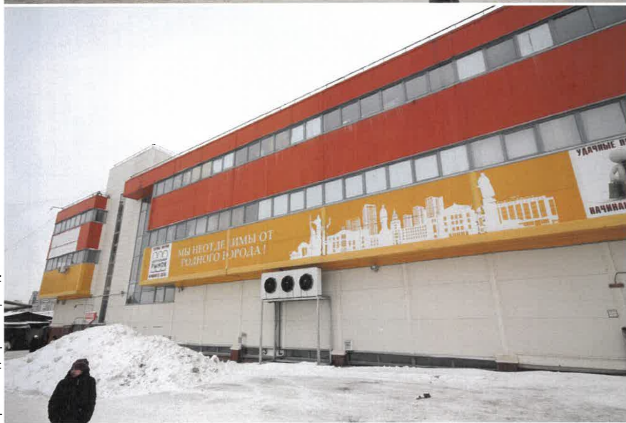
Фрагмент дворового фасада
