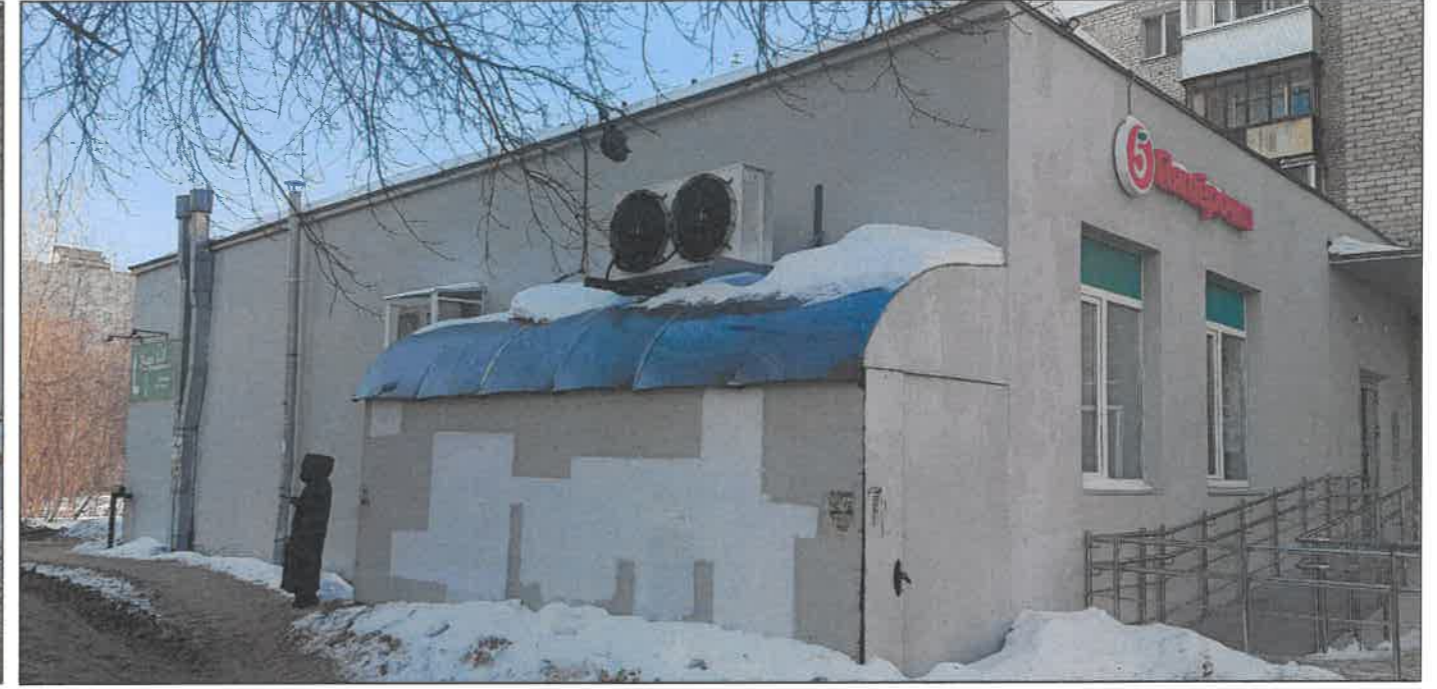
Пристрой в осях 2-3
