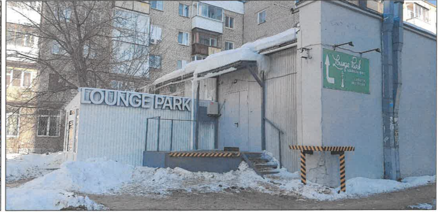
Пристрой в осях 2-3
