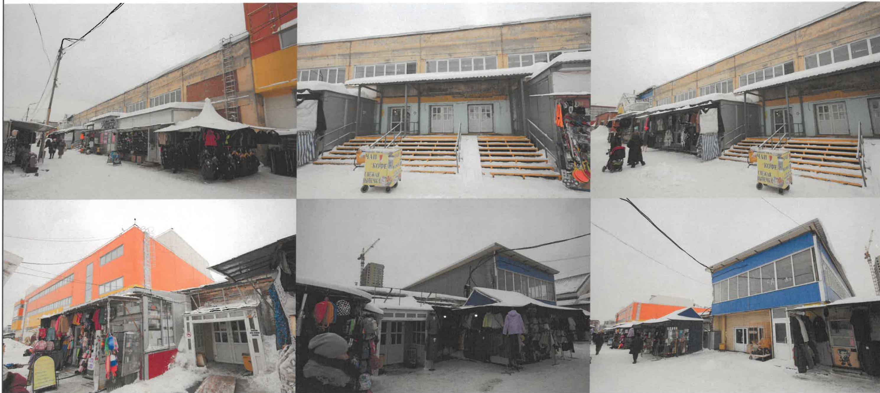
Фрагменты дворового фасада
