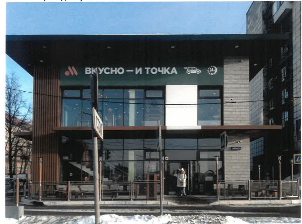
Главный фасад по ул. Попова
