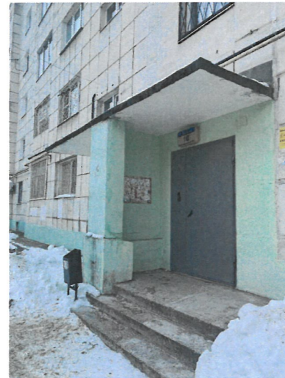
Фрагмент дворового фасада
