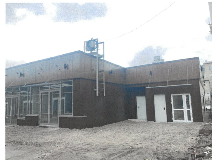
Фрагмент бокового и дворового фасадов
