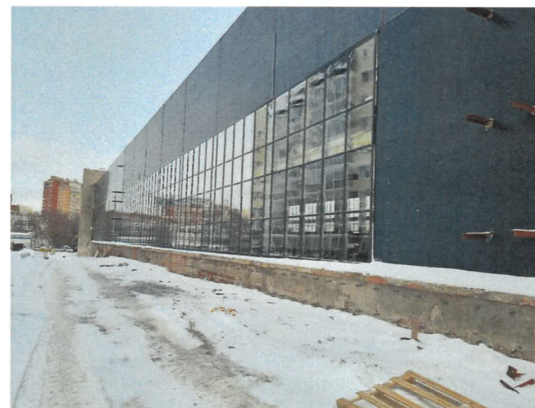
Фасад со двора
