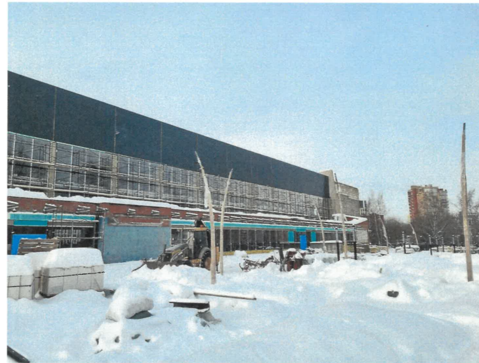
Главный фасад с ул. Рабочая
