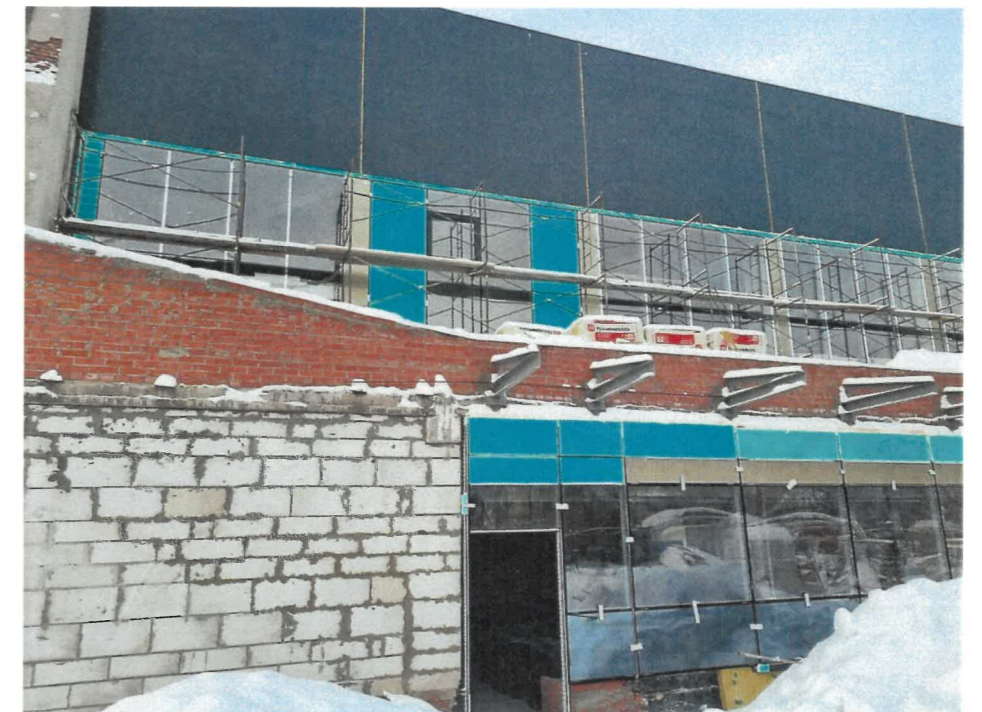
Главный фасад с ул. Рабочая
