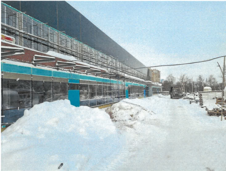
Главный фасад с ул. Рабочая
