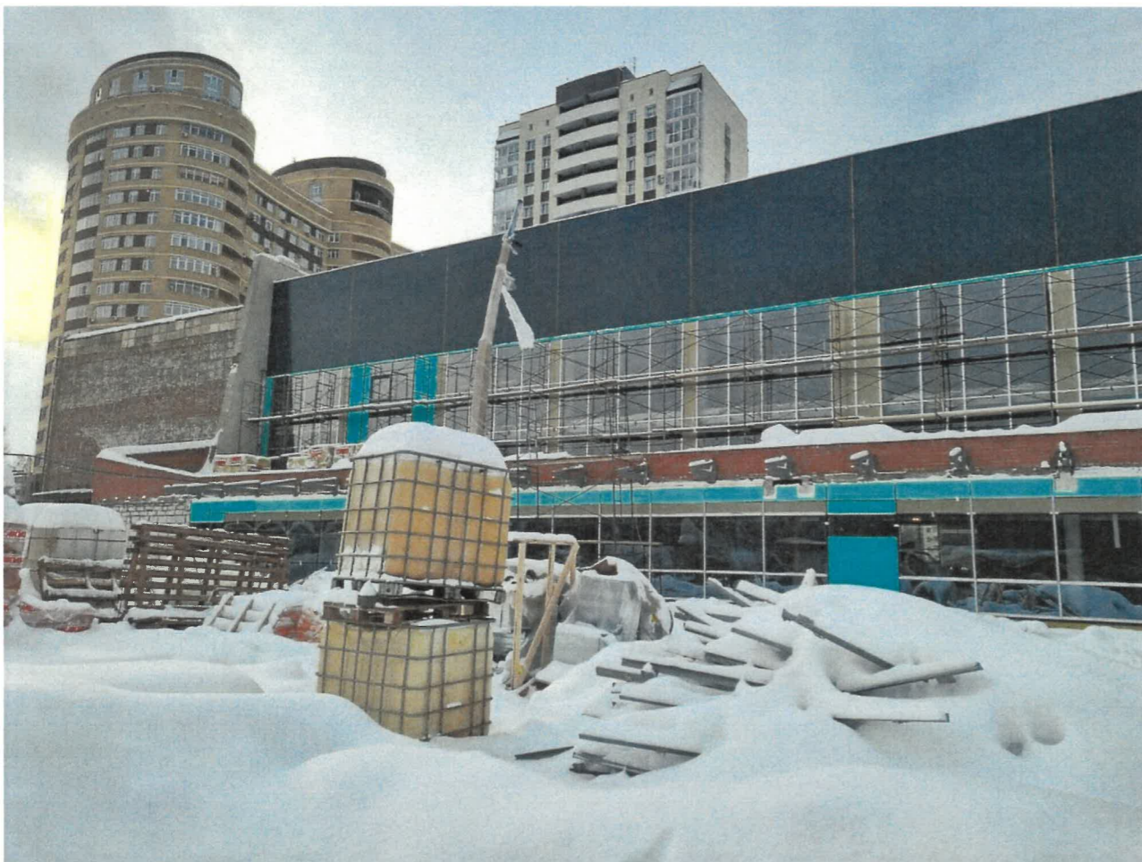
Главный фасад с ул. Рабочая
