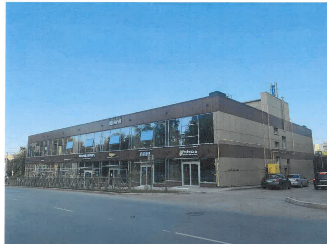
Главный фасад по ул. Белинского. Дворовой фасад.
