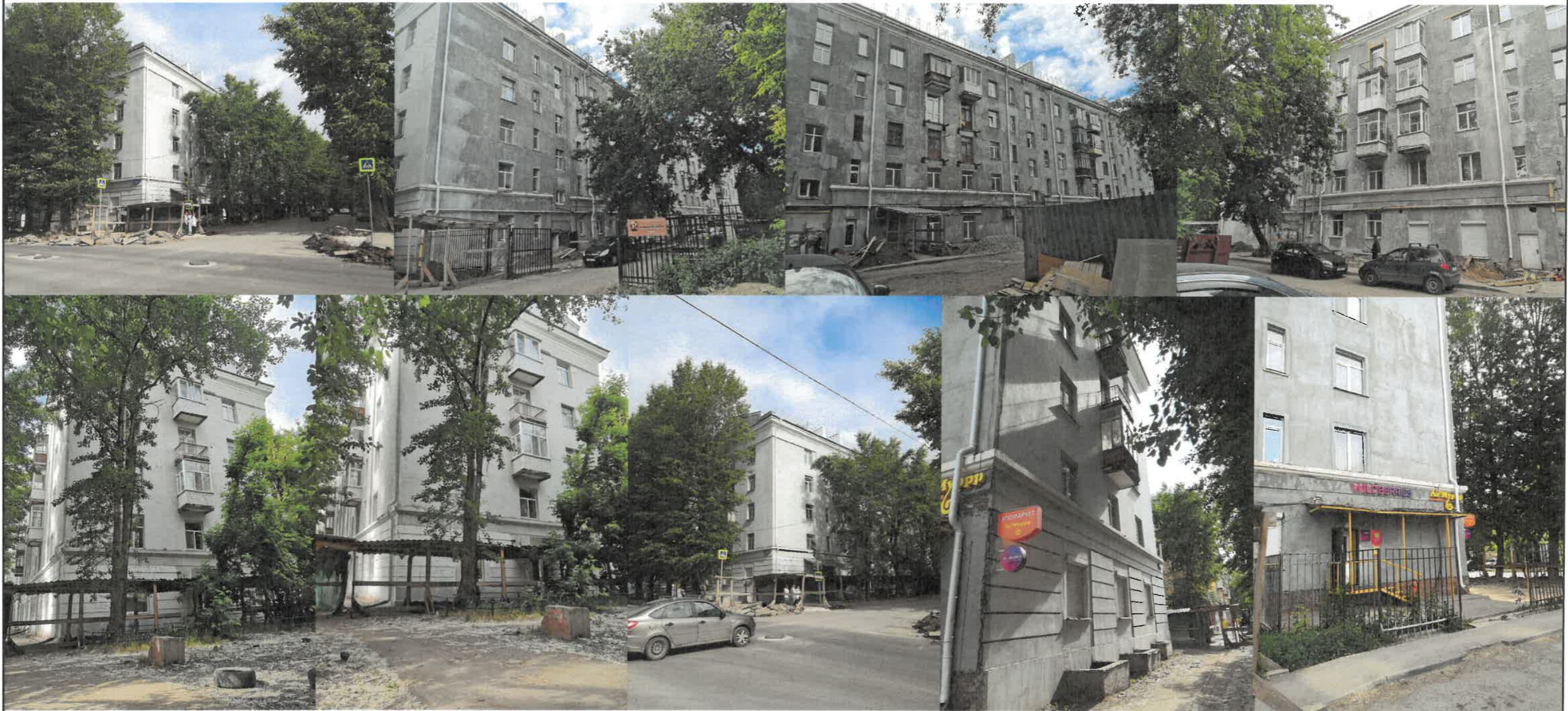
фотофиксация выполнена июнь 2023 (идет капитальный ремонт МКД по адресу: г. Пермь, Мотовилихинский район, ул. Лебедева, 35.
