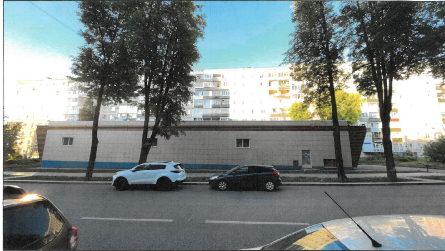
Главный фасад по ул. Газеты Звезда
