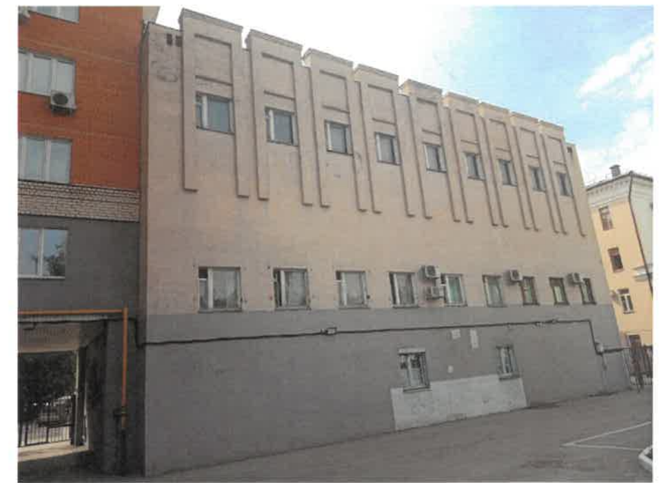
Дворовой фасад в осях 6-10
