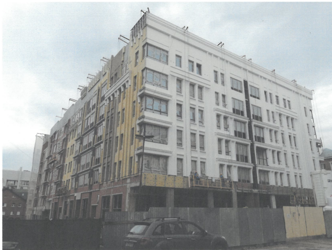
Боковой фасад. Вид со стороны ЦУМа
