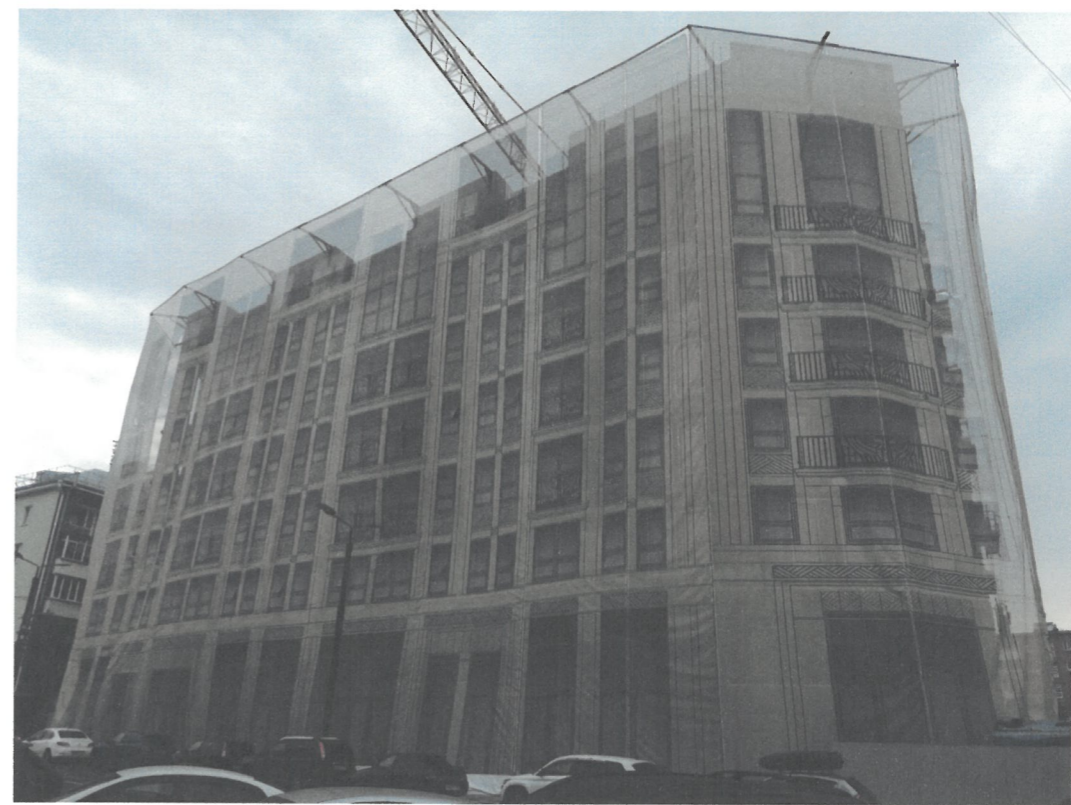
Главный фасад. Вид по ул. Петропавловская
