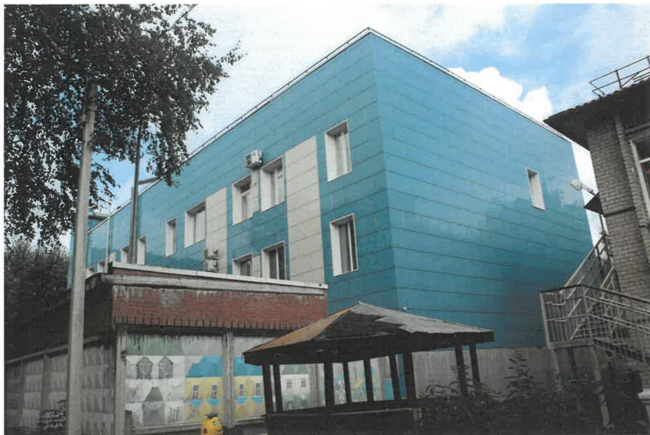
Существующее состояние фасадов. Боковые фасады.
