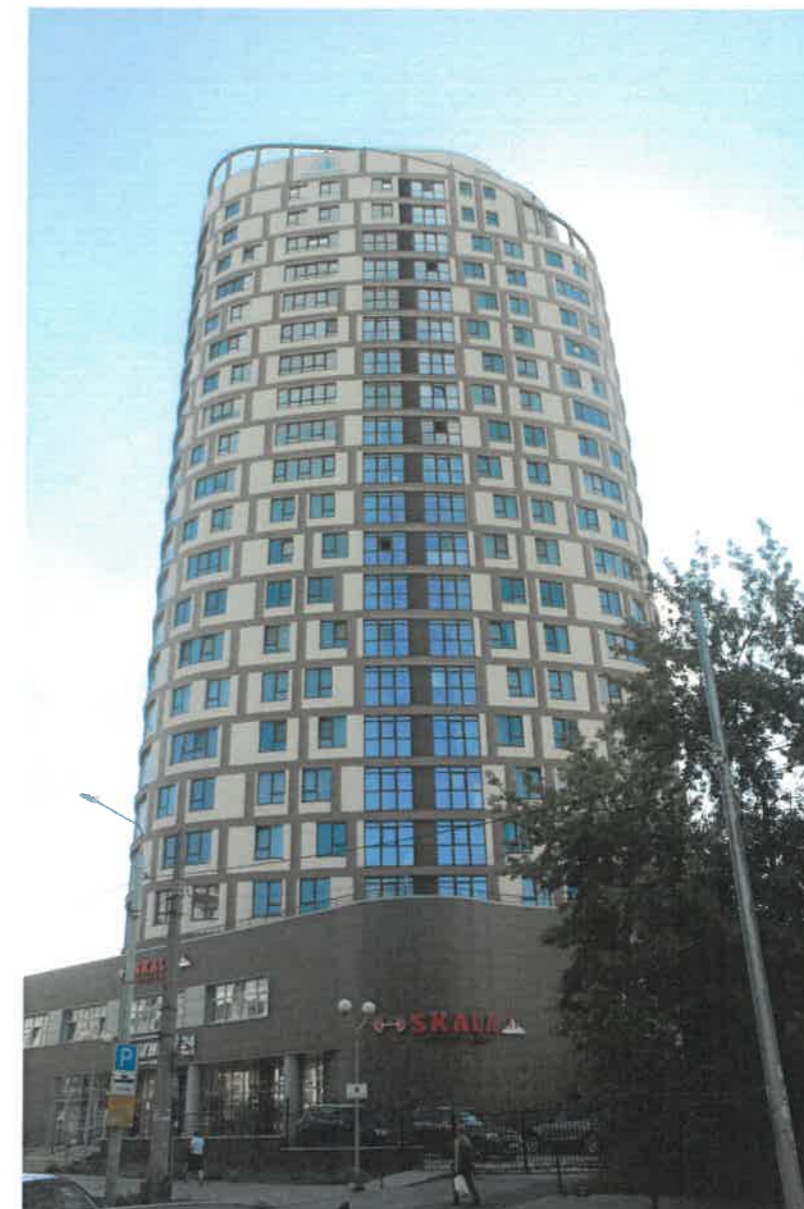
Существующее состояние фасадов. Боковой фасад.
