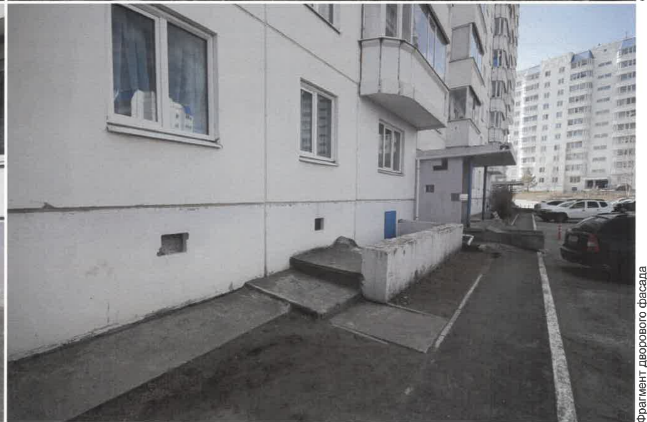
Фрагмент дворового фасада
