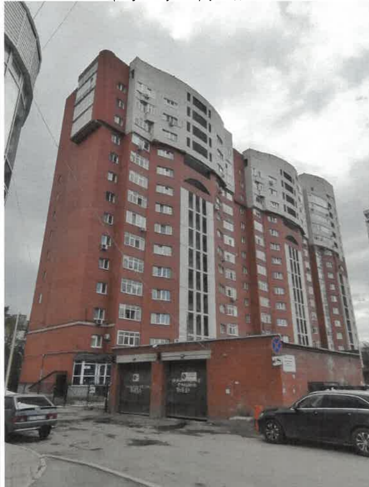
Боковой и главный (по ул. Окулова) фасады
