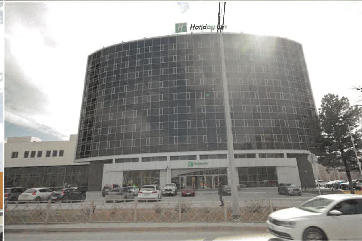
Фрагмент главного фасада в осях 2-3
