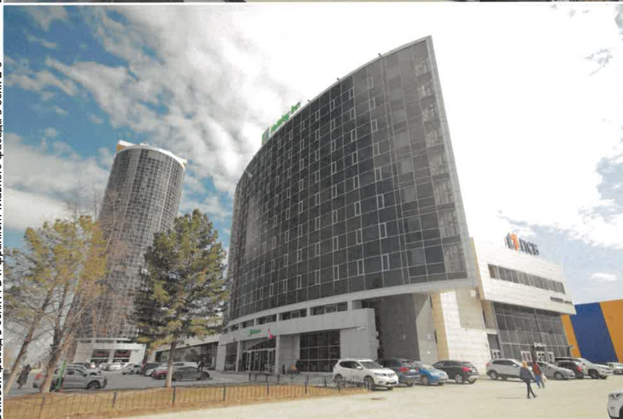
Боковой фасад в осях А-В и фрагмент главного фасада в осях 2-3
