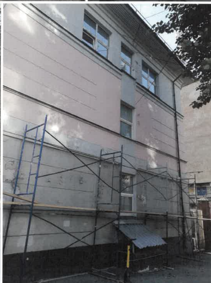
Боковой фасад (фрагмент)
