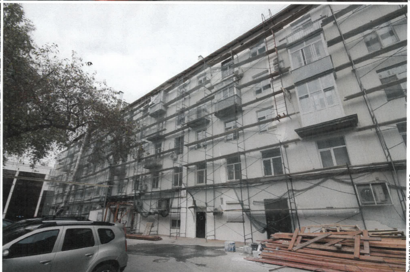
Фрагмент дворового фасада
