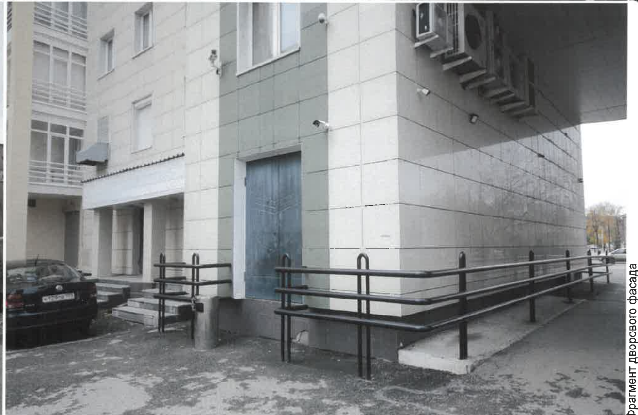
Фрагмент дворового фасада
