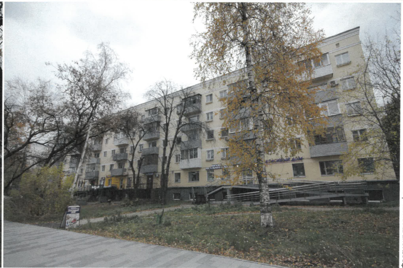
Фрагмент главного фасада
