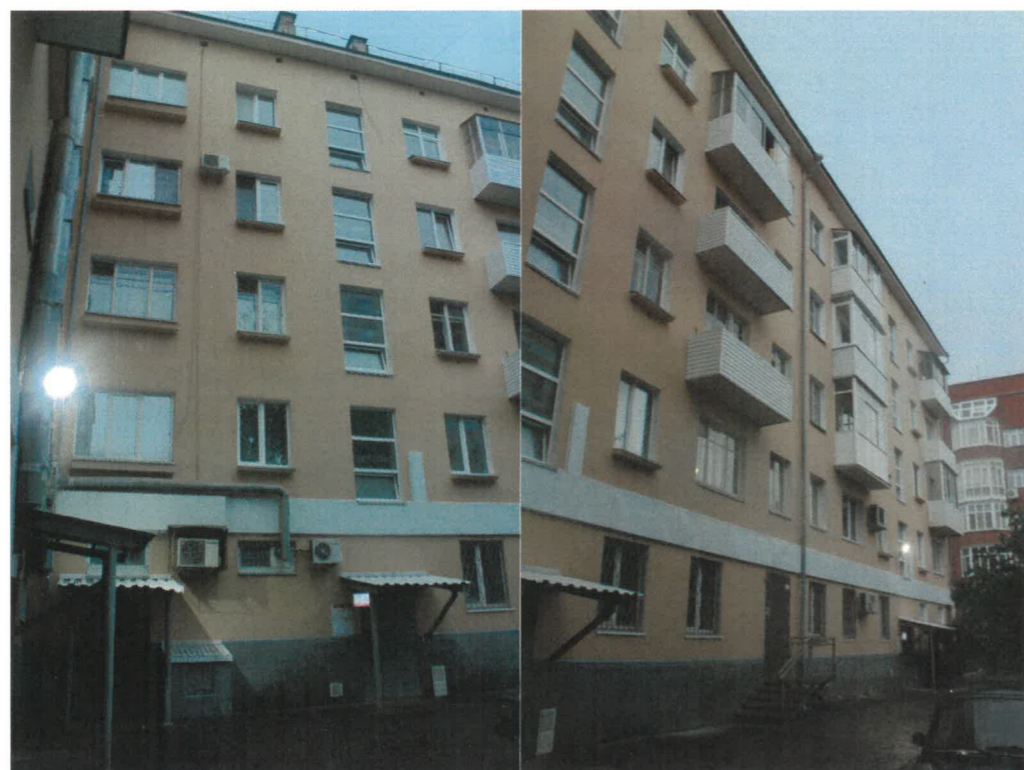
Существующее состояние дворового фасада
