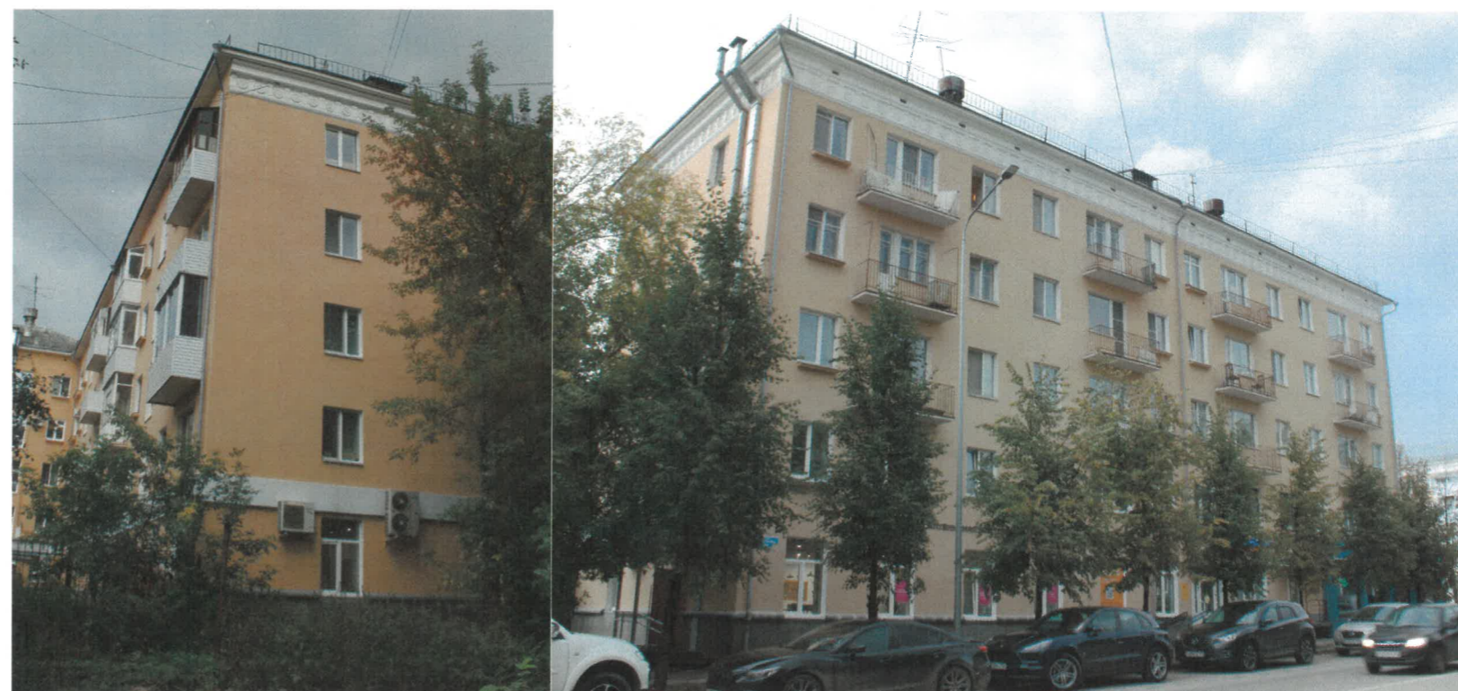
Существующее состояние торцевого фасада по улице Краснова
