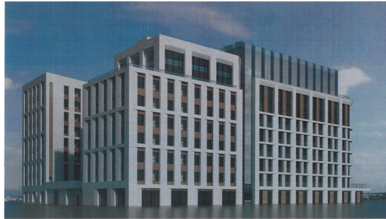
Видовая точка №2. Фасад по ул. Советская, торцевые фасады
