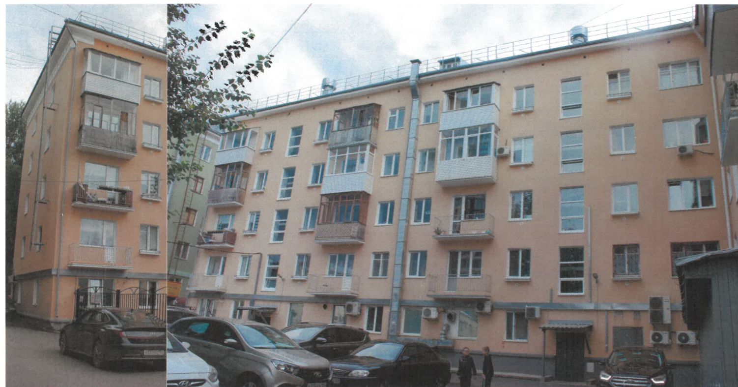
Существующее состояние дворового фасада
