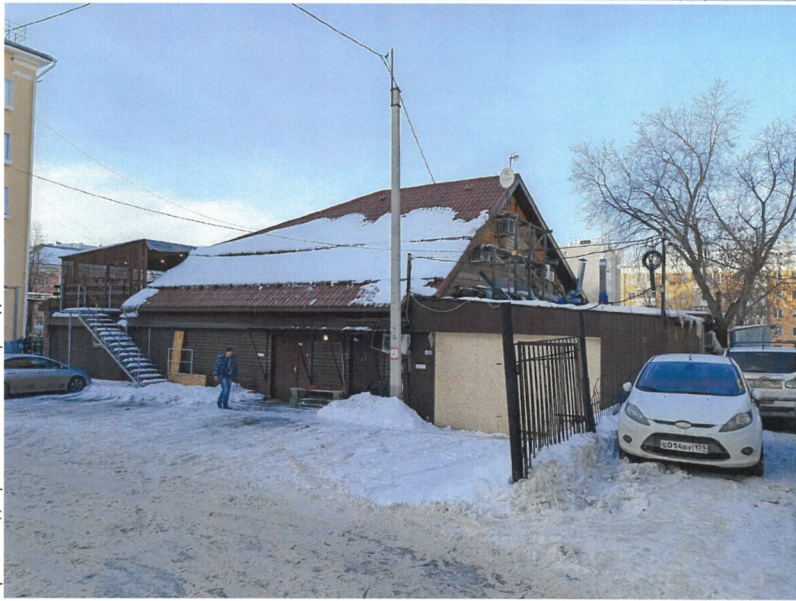
Фрагмент дворового и боковой фасады
