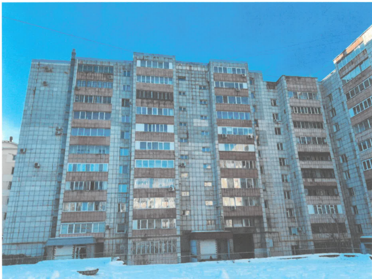
Существующее состояние дворового фасада
