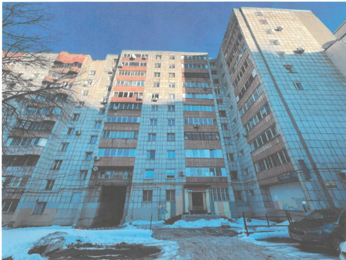
Существующее состояние главного фасада со стороны Комсомольского проспекта
