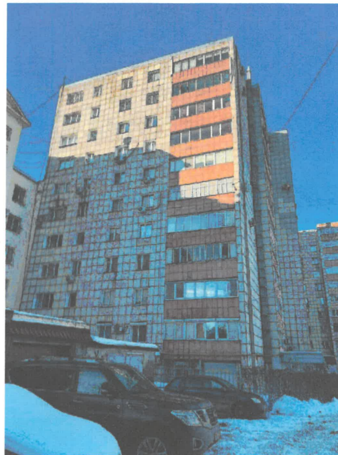
Существующее состояние главного фасада со стороны ул.Пушкина
