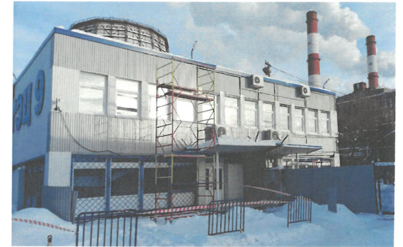
Существующее состояние фасадов. Боковые фасады.
