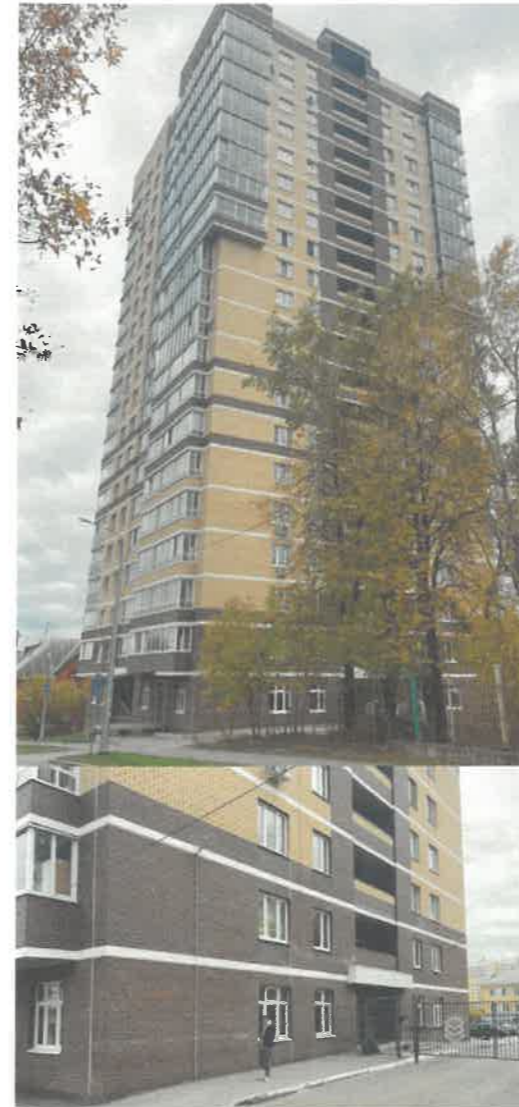
Боковой фасад Дата съемки: 29.09.2023
