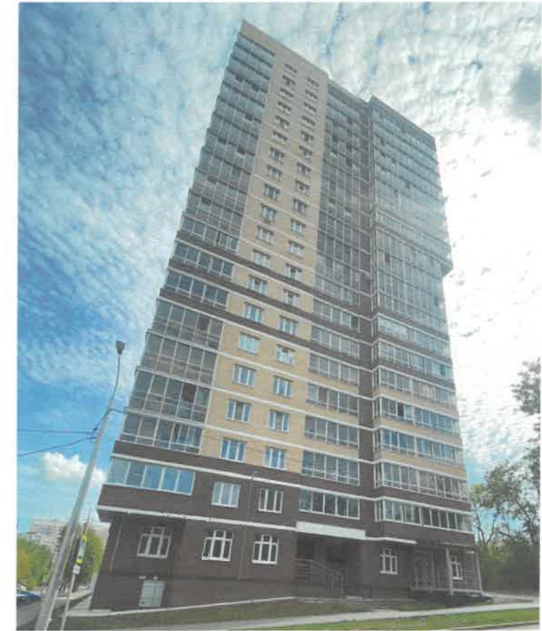
Боковой фасад Дата съемки: 29.09.2023
