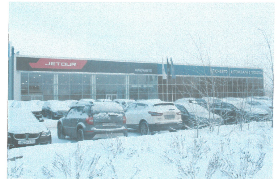
Главный фасад (правое крыло)
