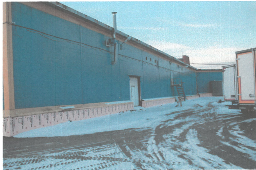
Дворовой фасад правого крыла
