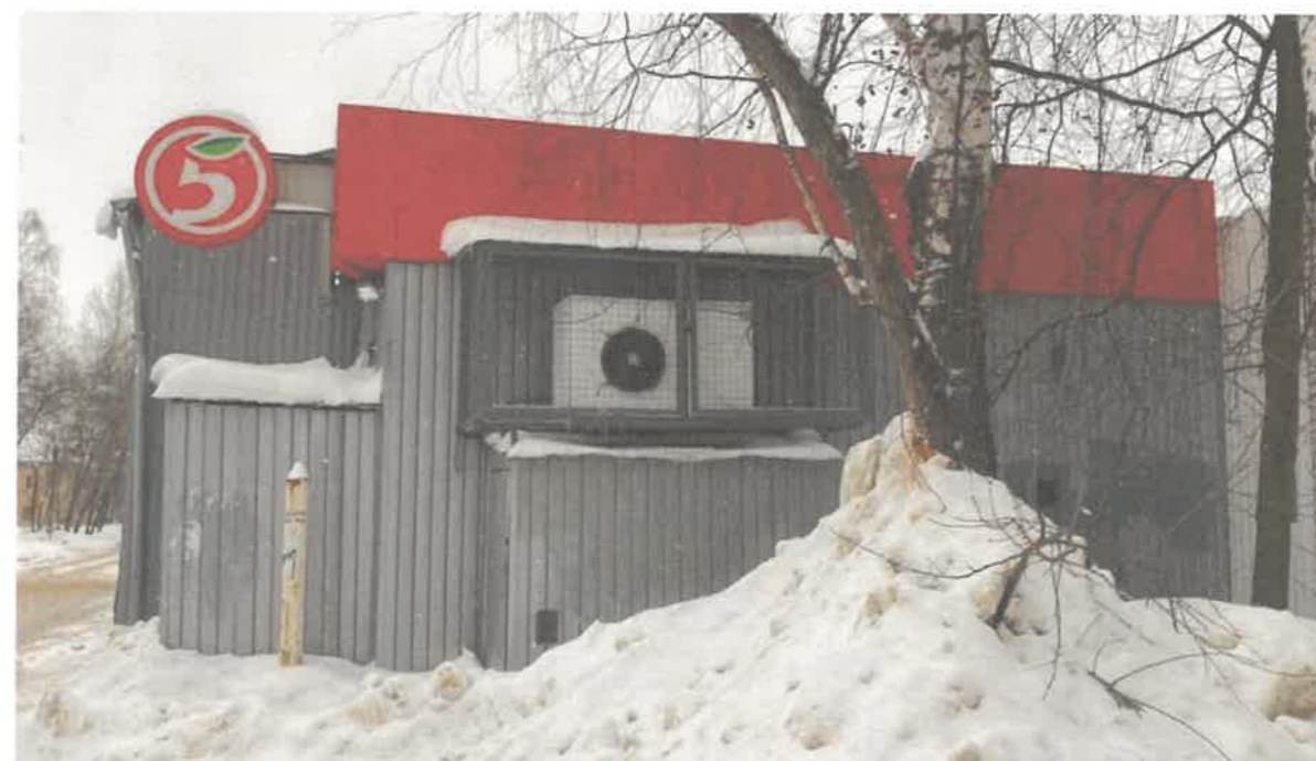
Боковой фасад Дата съемки: 03.02.2024
