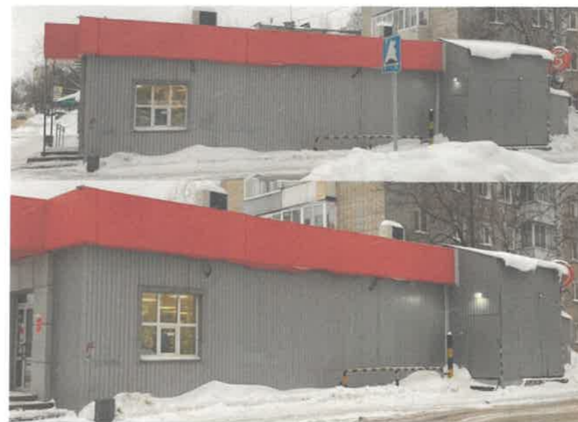
Боковой фасад Дата съемки: 03.02.2024
