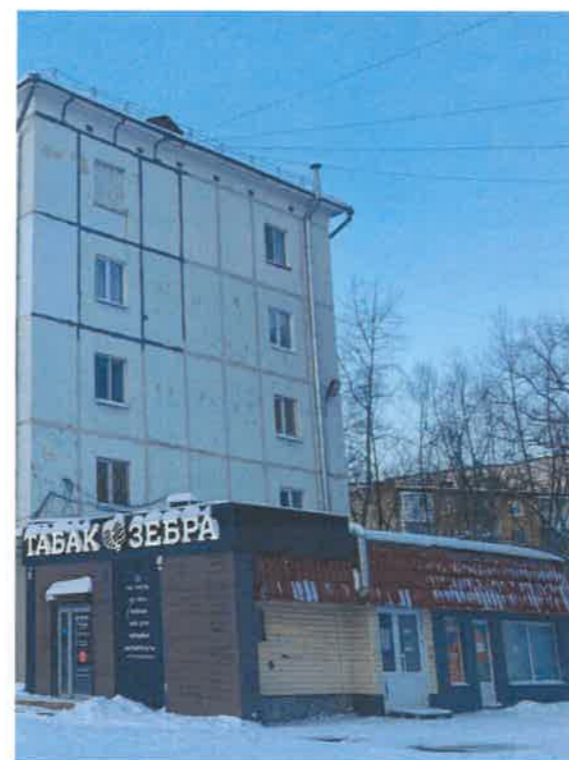
Боковой фасад Дата съемки: 04.02.2024
