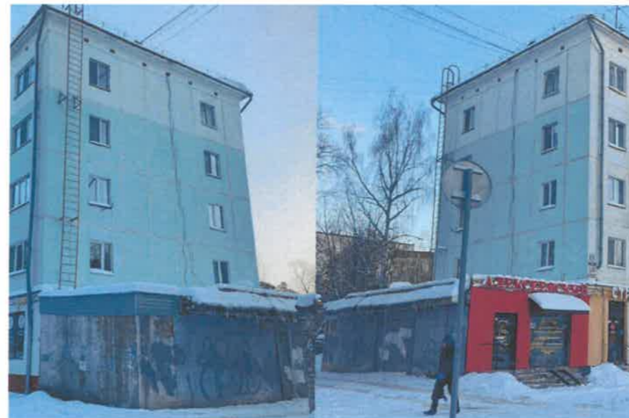
Боковой фасад Дата съемки: 04.02.2024
