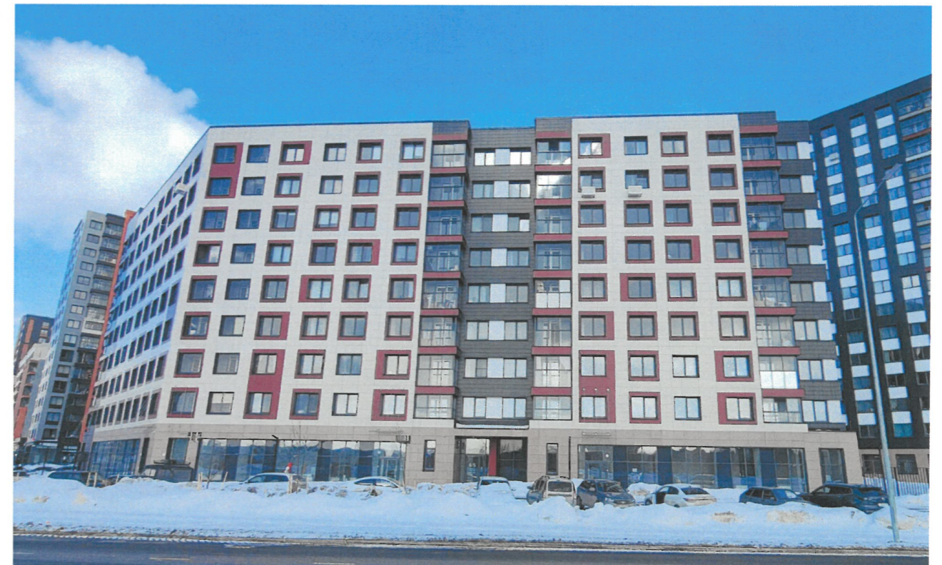
Фотофиксация фасадов выполнена 11.03.2024 г.
