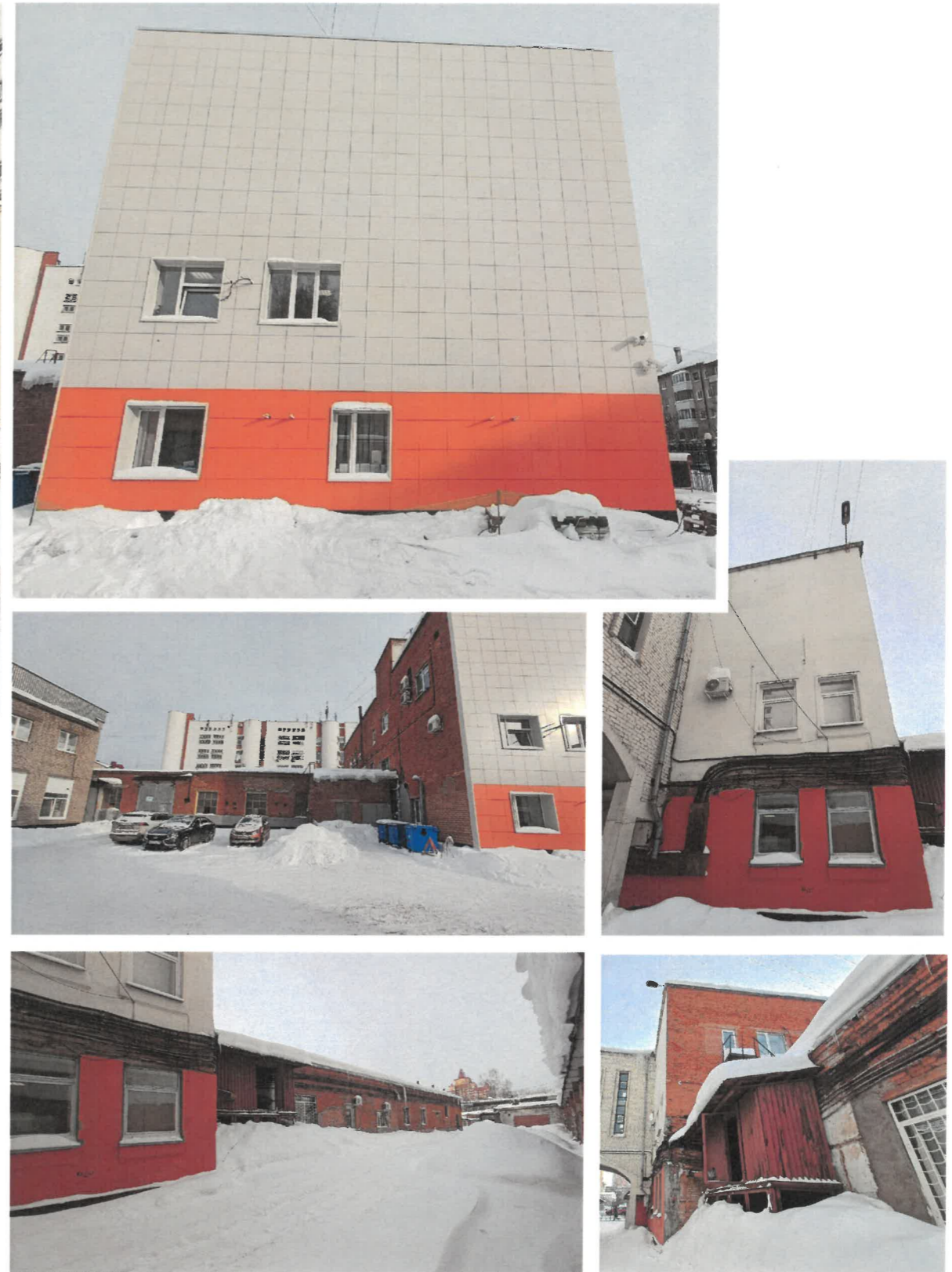
Существующее состояние фасадов. Боковые фасады.
