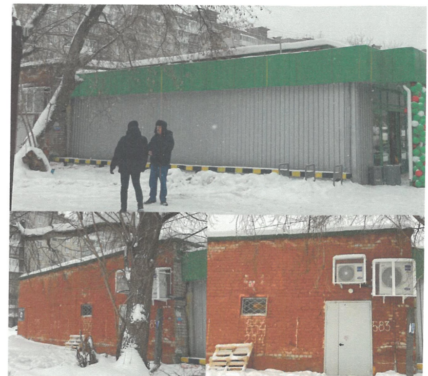
Боковой фасад Дата съемки: 03.03.2024
