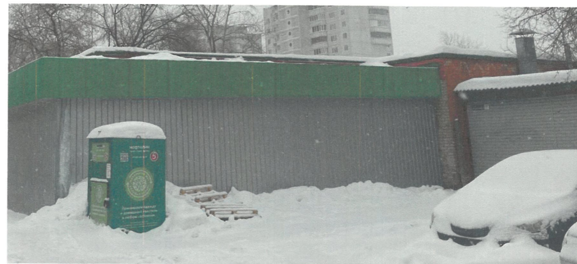
Боковой фасад Дата съемки: 03.03.2024
