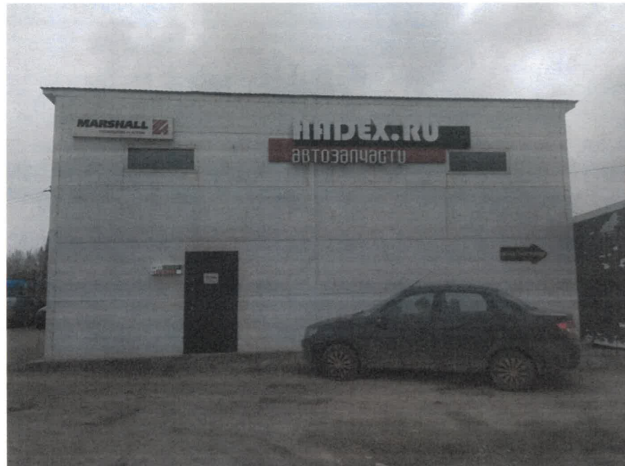
Главный фасад (1А-1Б по ул. Космонавта Леонова)
