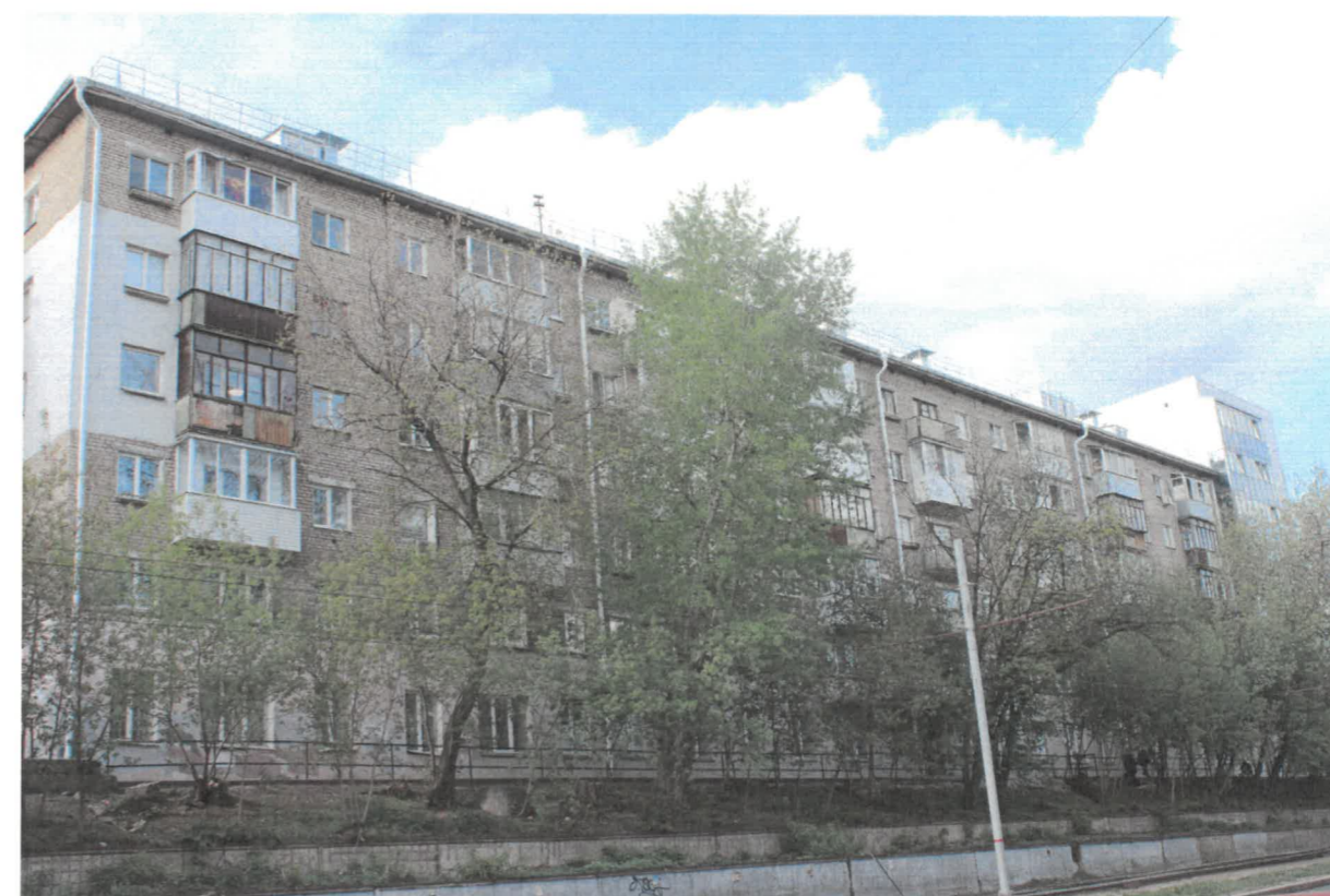
Существующее состояние дворового фасада в осях 1-10
