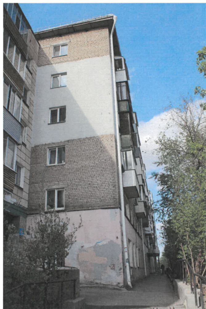
Существующее состояние бокового фасада в осях В-А
