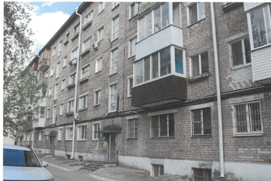
Существующее состояние дворового фасада в осях 10-1
