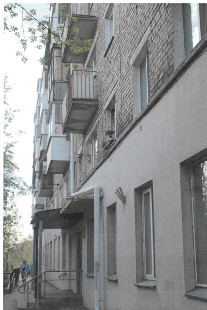
Фрагмент главного фасада в осях 1-10
