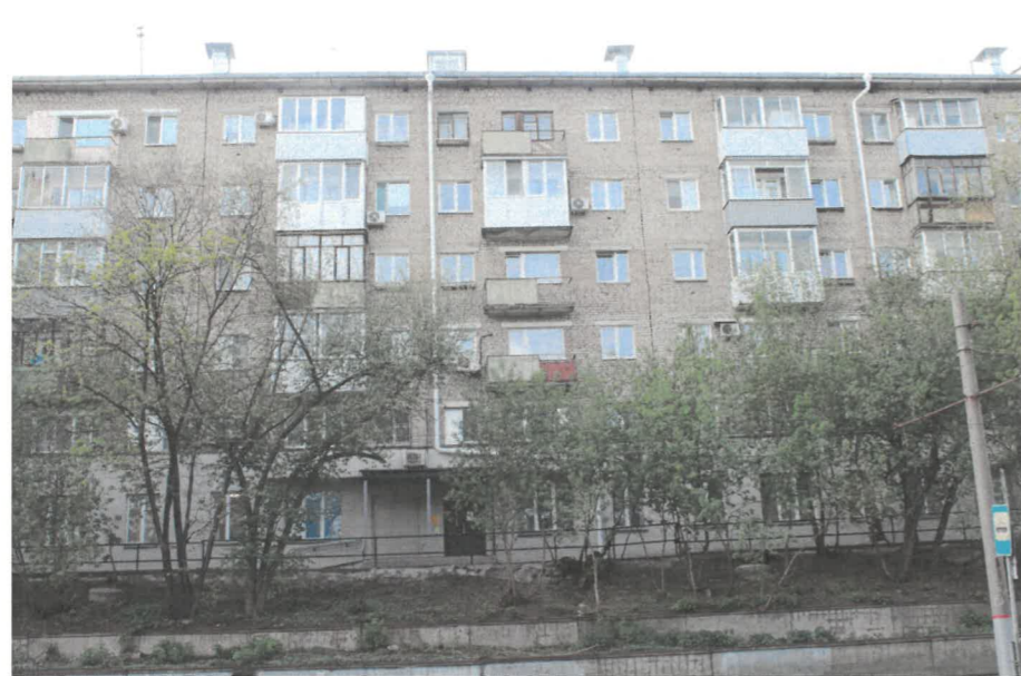
Существующее состояние главного фасада в осях 1-10
