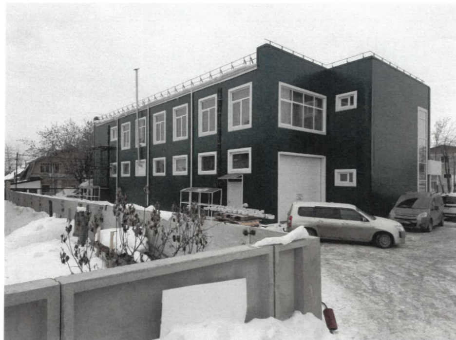
Существующее состояние фасадов. Дворовый фасад.
