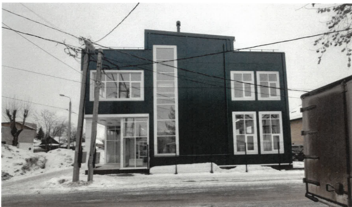
Существующее состояние фасадов. Боковые фасады.
