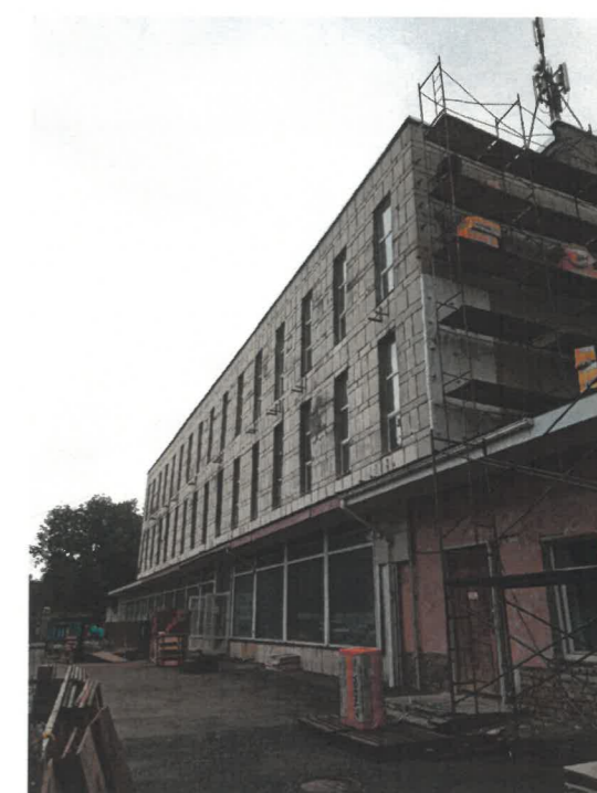
Существующее состояние бокового фасада (южного)
