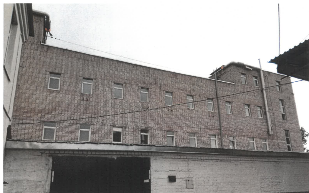
Существующее состояние дворового фасада (восточного)
