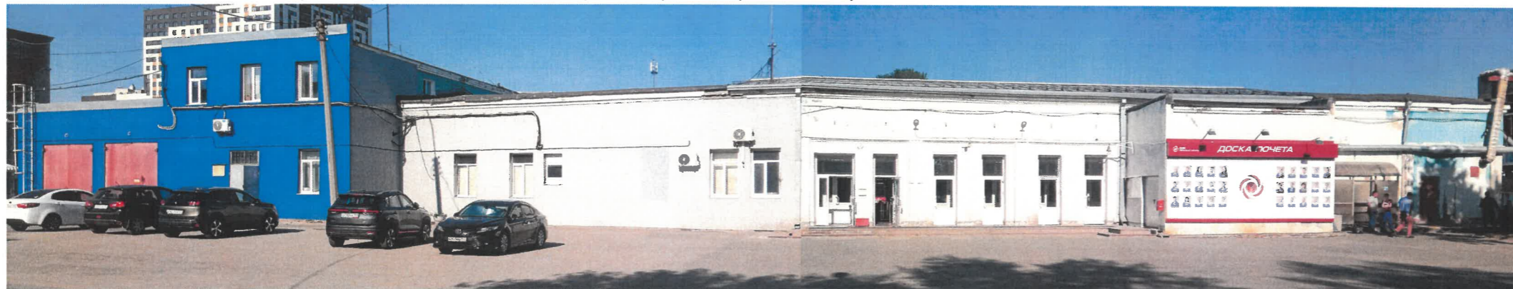
Существующее состояние дворового фасада (восточного)
