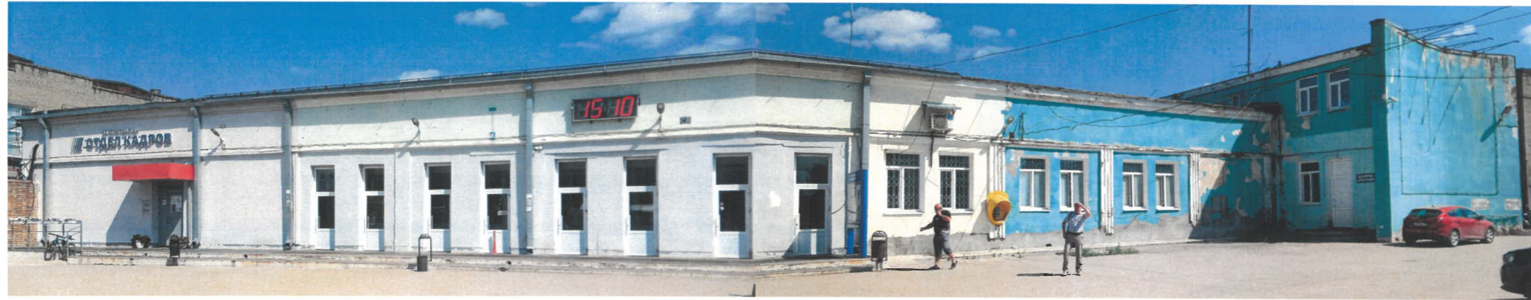
Существующее состояние главного фасада (западного)
