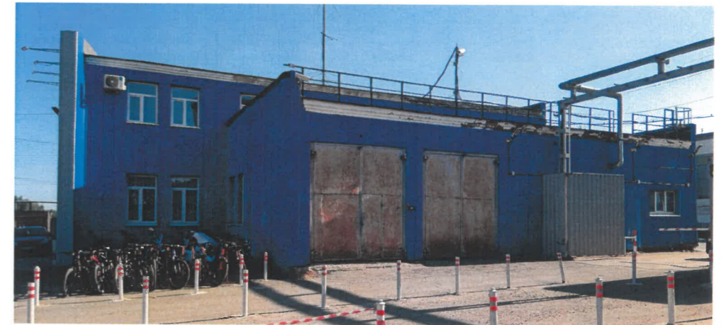
Существующее состояние бокового фасада (южного)
