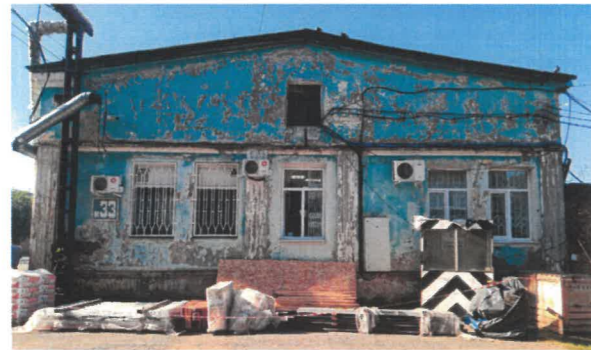
Существующее состояние бокового фасада (северного)
