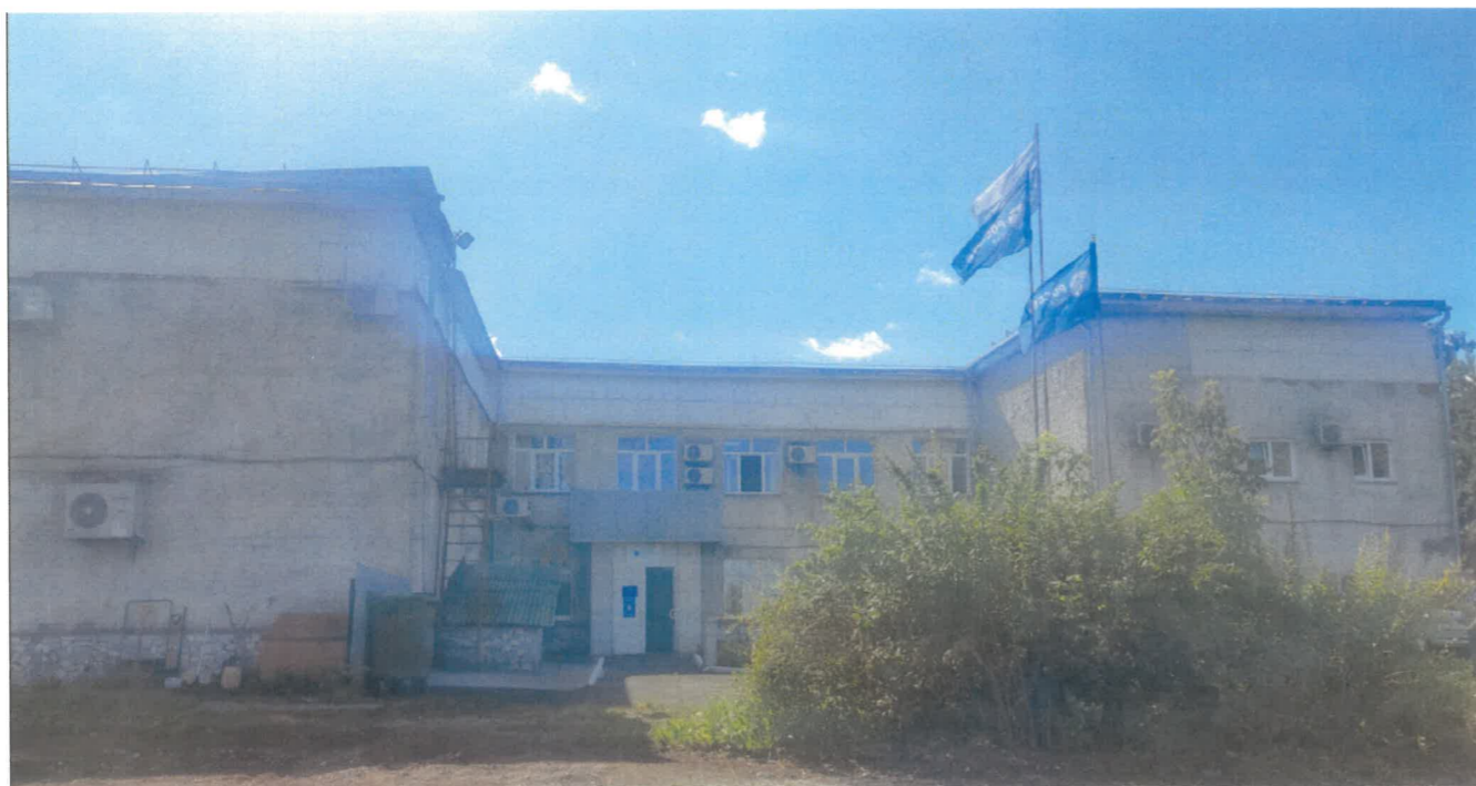
Существующее состояние главного фасада
