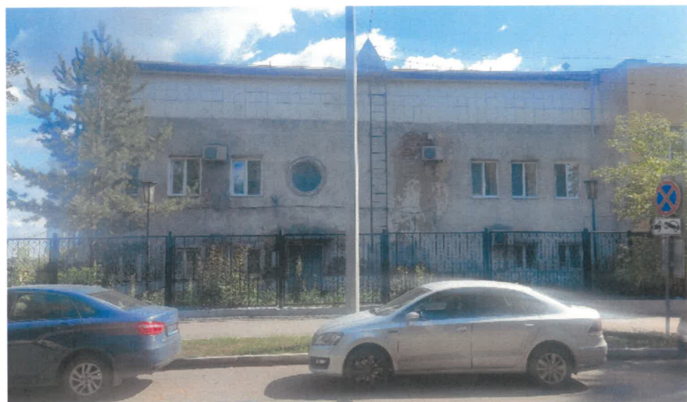
Существующее состояние бокового фасада
