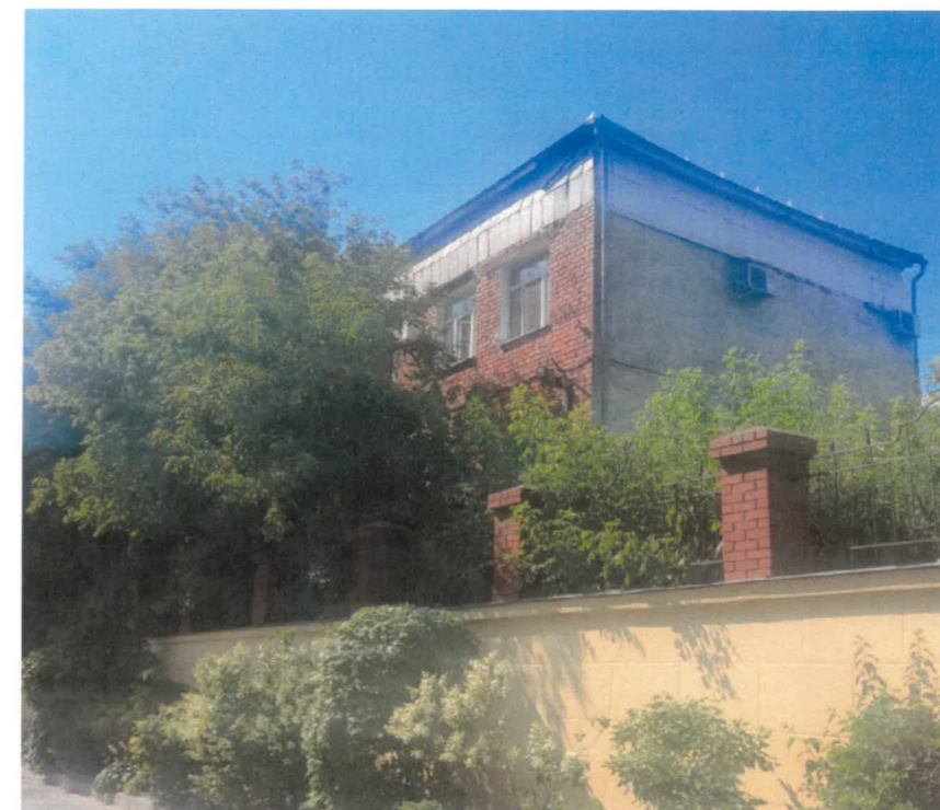
Существующее состояние бокового фасада
