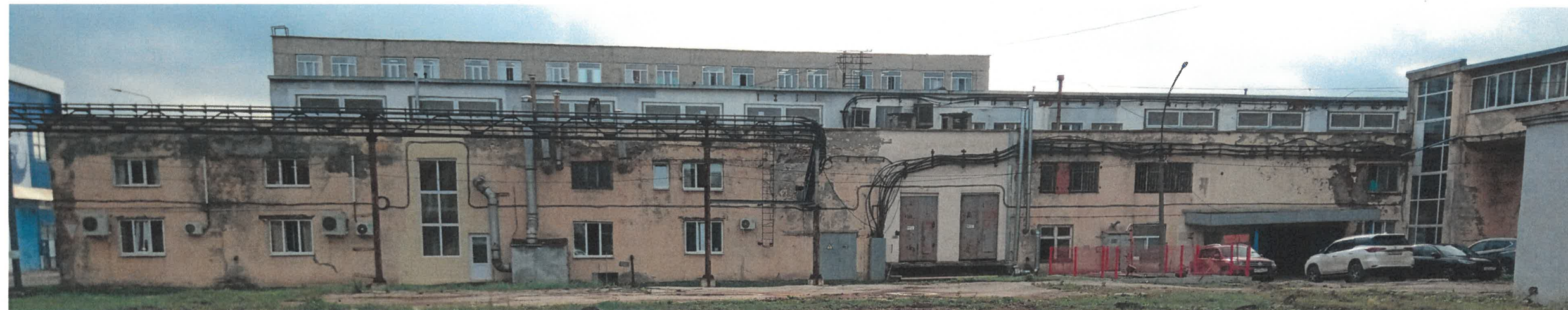
Существующее состояние бокового фасада (западного)
