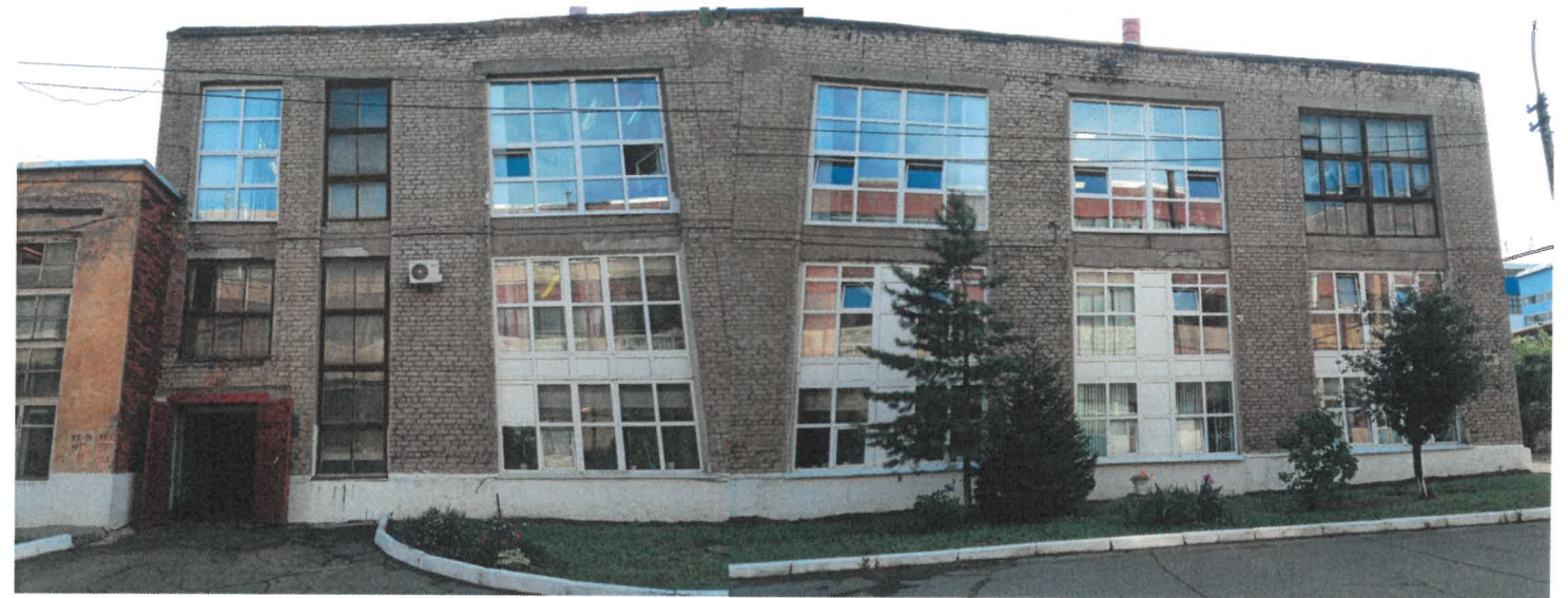
Существующее состояние бокового фасада (западного)
