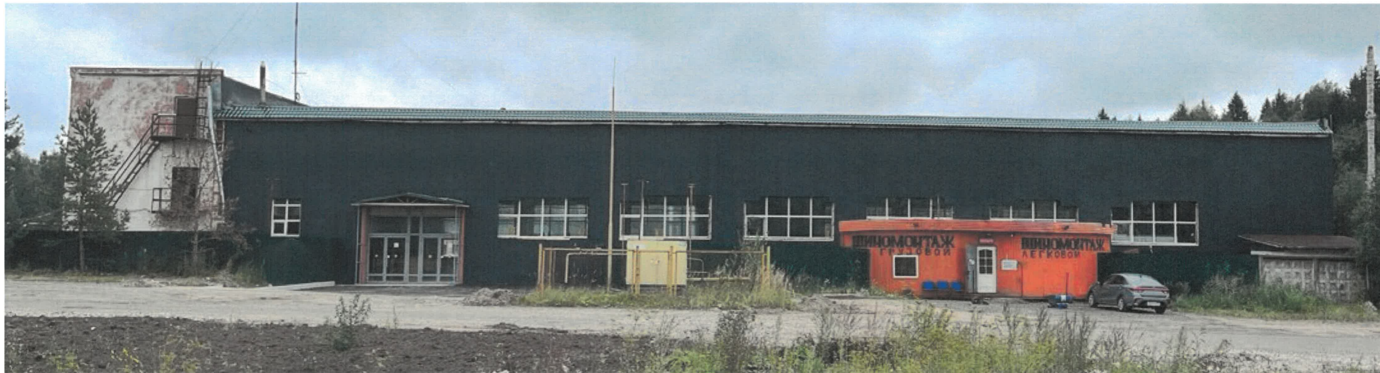
Существующее состояние фасадов. Боковой фасад.
