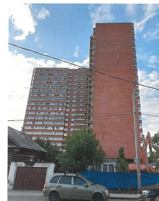
Дворовый и боковой фасады
