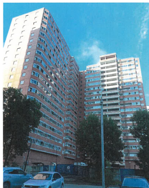
Боковой и дворовый фасады
