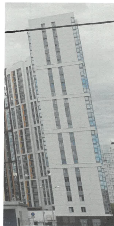
Боковой фасад (Дата съемки: 14.08.2024)
