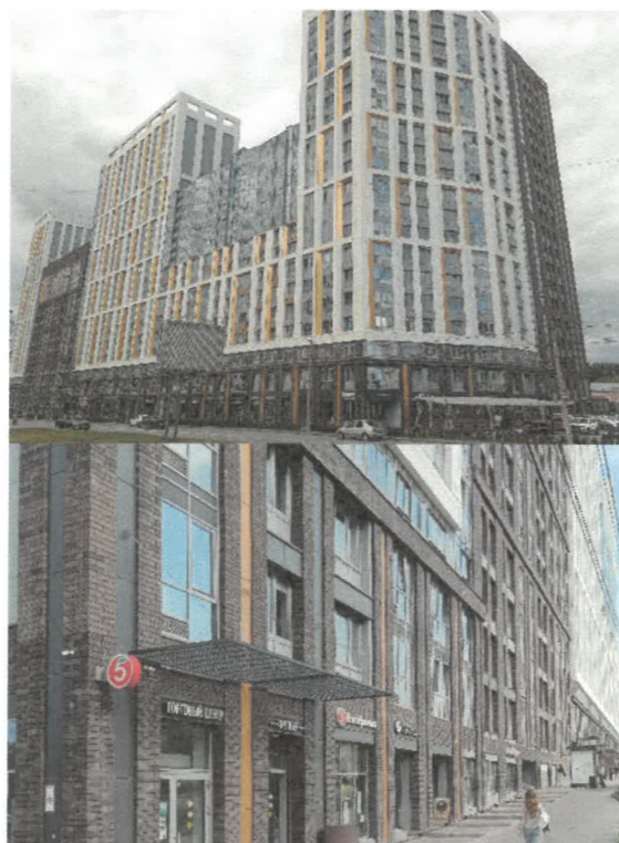
Главный фасад по ул. Н. Островского (Дата съемки: 14.08.2024)
