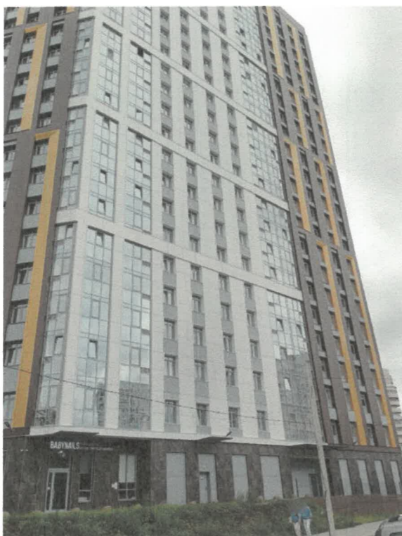
Боковой фасад по ул. Народовольческая (Дата съемки: 14.08.2024)
