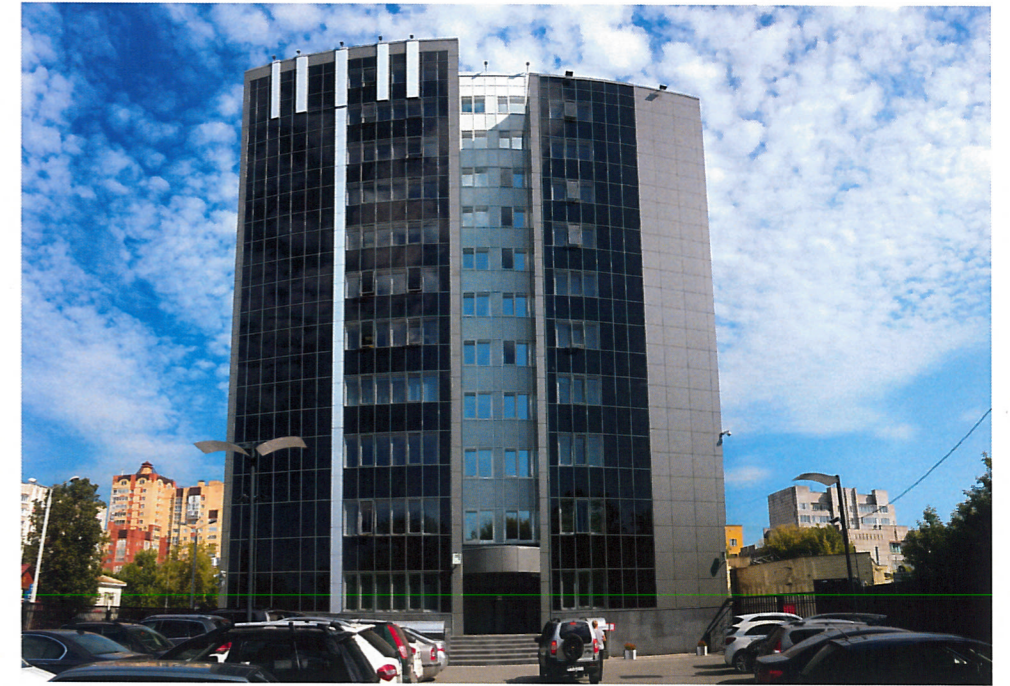
Существующее состояние бокового фасада (фотофиксация).
