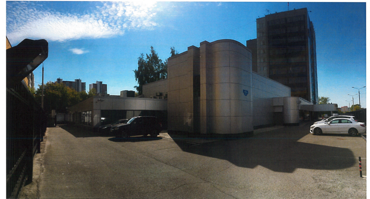
Существующее состояние бокового фасада (фотофиксация).
