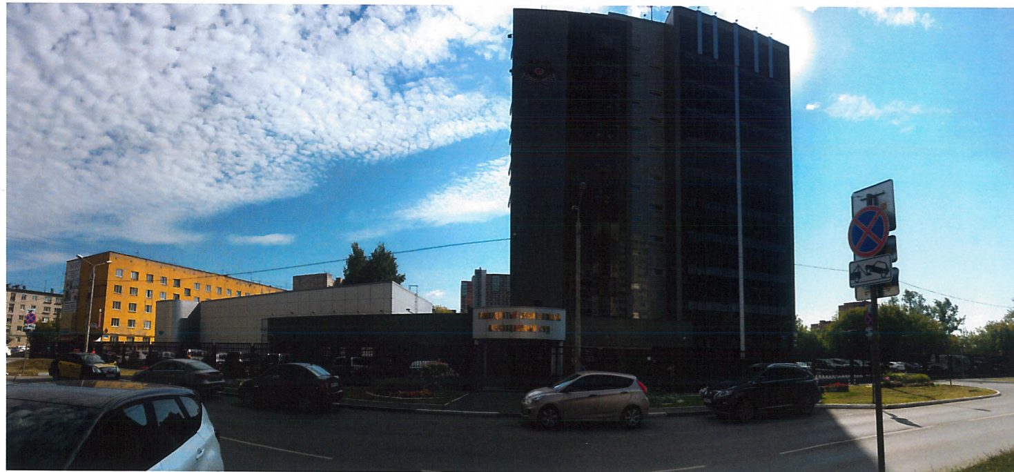
Существующее состояние главного фасада (фотофиксация).
