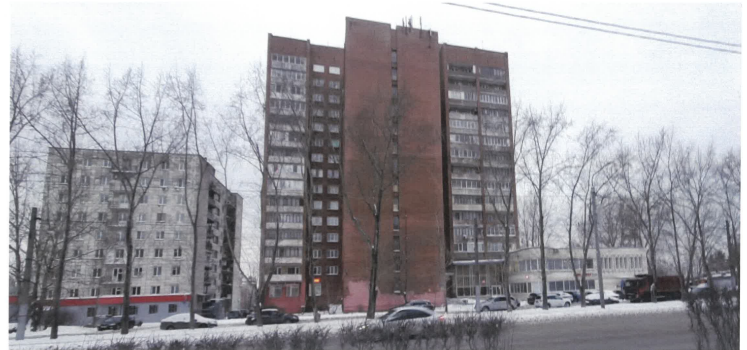
Существующее состояние главного фасада (фотофиксация вид Б)
