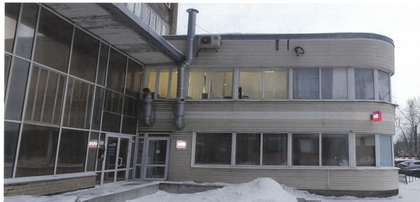
Существующее состояние главного фасада (фотофиксация вид Е)
