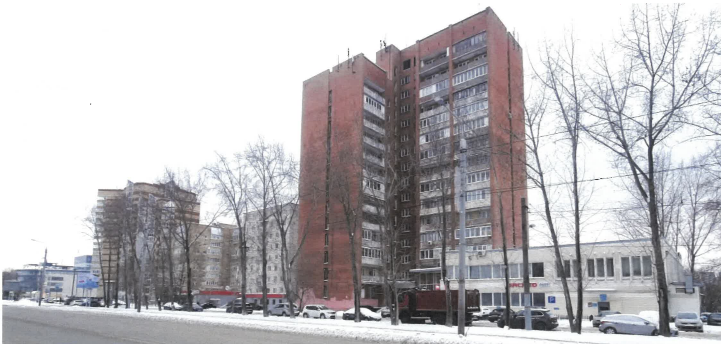
Существующее состояние главного фасада (фотофиксация вид В)
