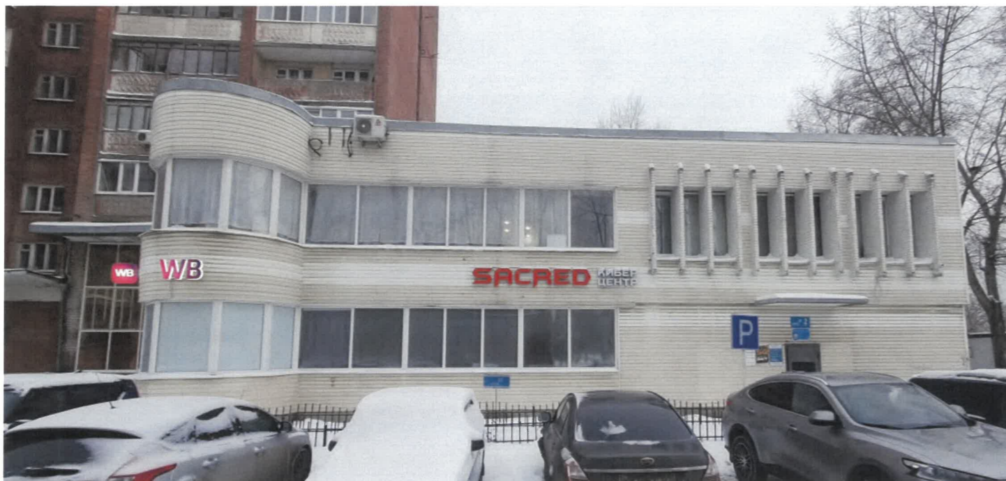
Существующее состояние главного фасада (фотофиксация вид Д)
