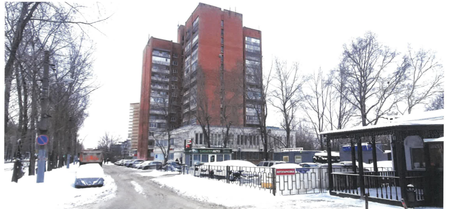
Существующее состояние главного фасада (фотофиксация вид Г)
