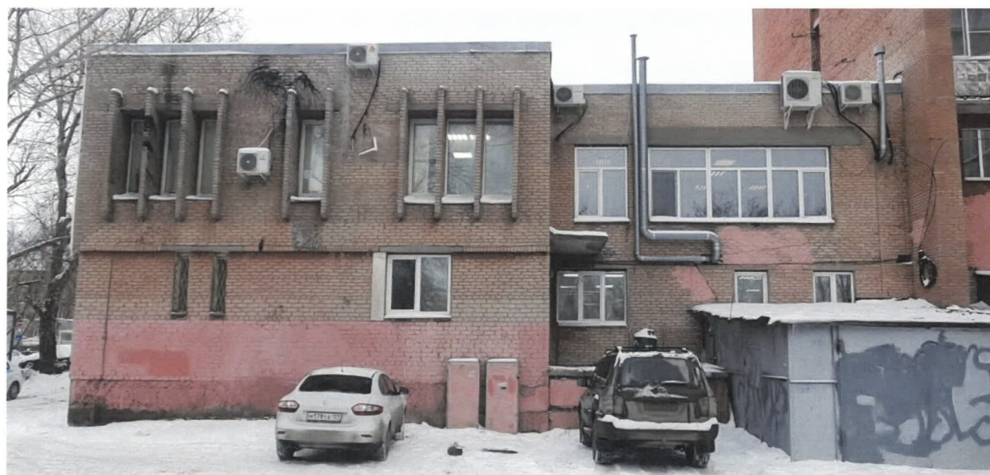
Существующее состояние дворового фасада (фотофиксация вид И)
