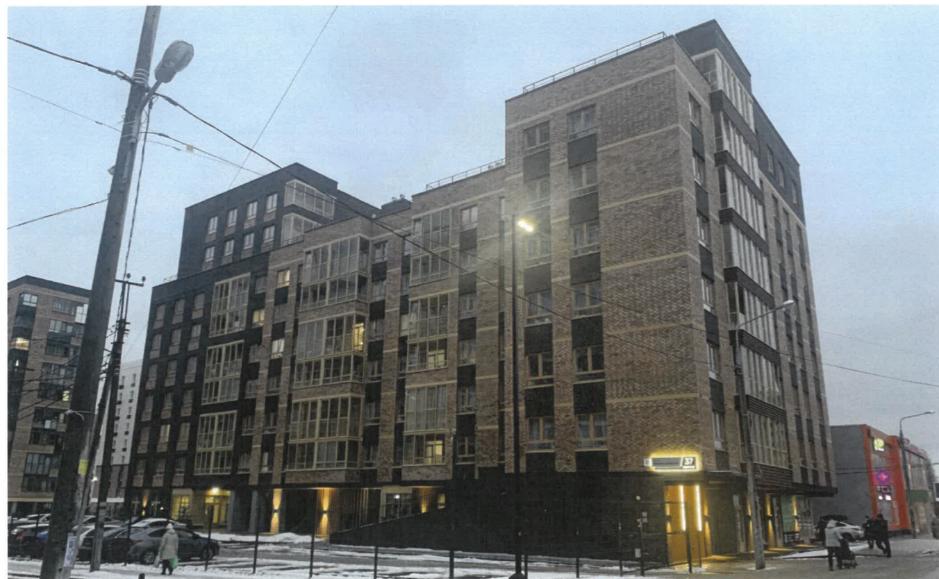
Главный фасад с ул.Молодогвардейской
